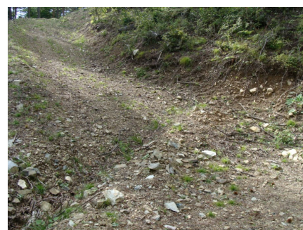
素掘りによる横断溝
