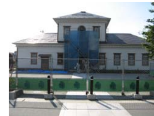
■小桜館改修 (平成23年3月完成予定)
