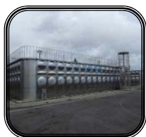
【写真 清水町浄配水場 配水池】
