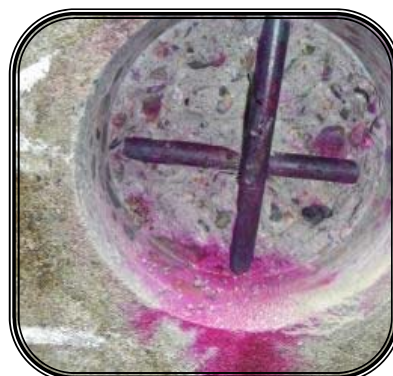
【写真 中性化試験(平野配水池)】
