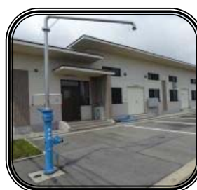
【写真 応急給水塔】
