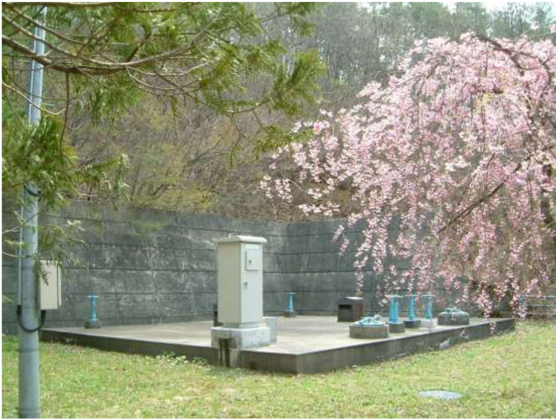
上地区配水池
