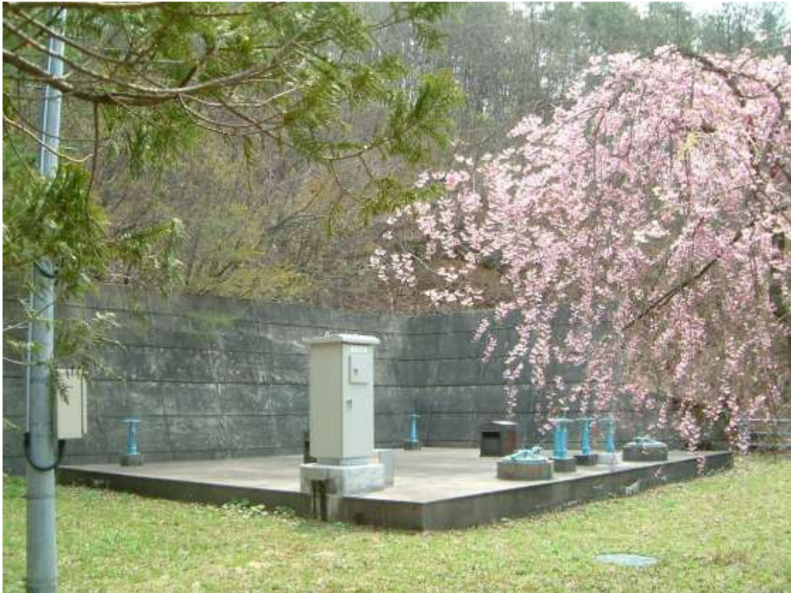
上地区配水池
