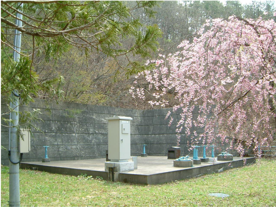
上地区配水池
