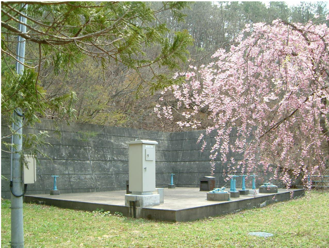
上地区配水池
