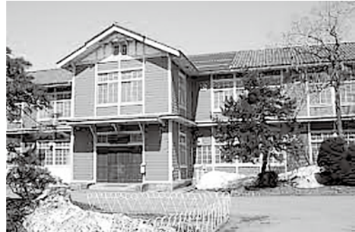
保存活用を検討する長井小学校第一校舎
