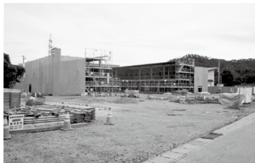
建設中の観光交流センター
