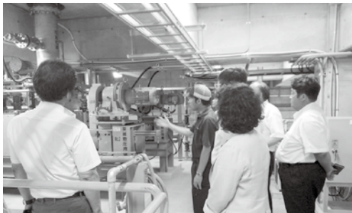
生ごみバイオマス発電施設内
