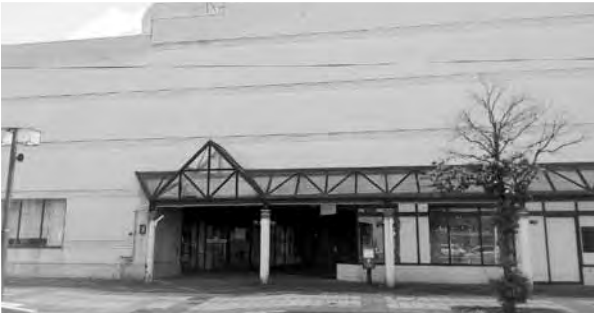
商業施設の入居が待たれるタウンセンタービル
