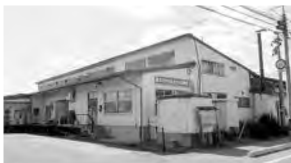
老朽化している学校給食共同調理場
