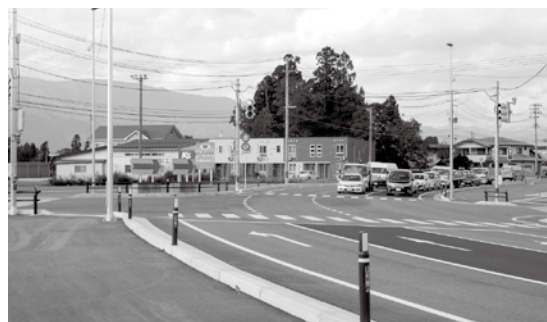
建設が要望されている西廻り幹線道路
