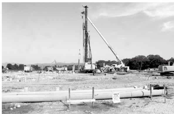
地盤整備が進む建設予定地
