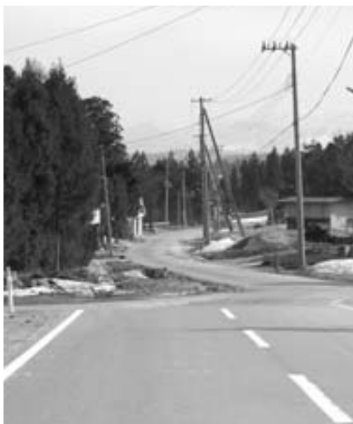
整備が進む大沢線
