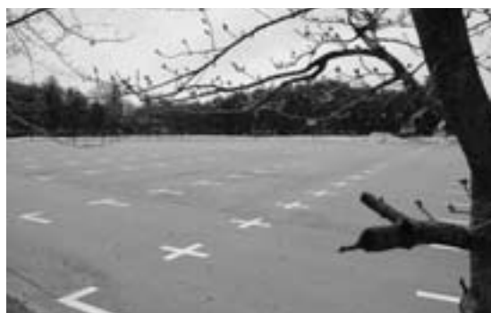
完成した多目的広場
