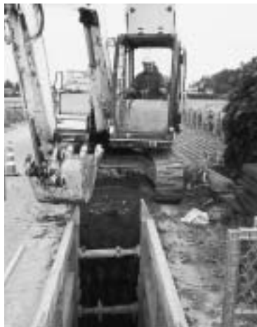
着実に工事が進む第4期「公共下水道」
