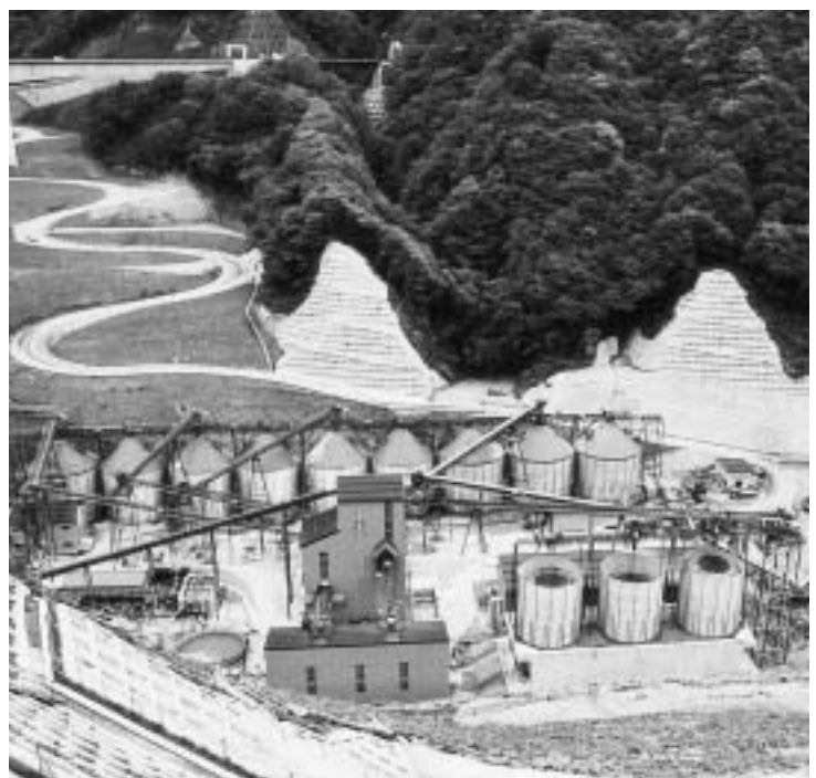
着々と工事が進む長井ダム
