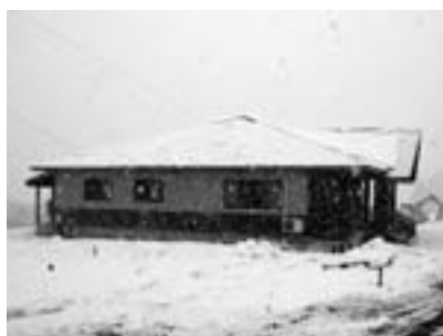
完成した道照寺平コミュニティセンター
