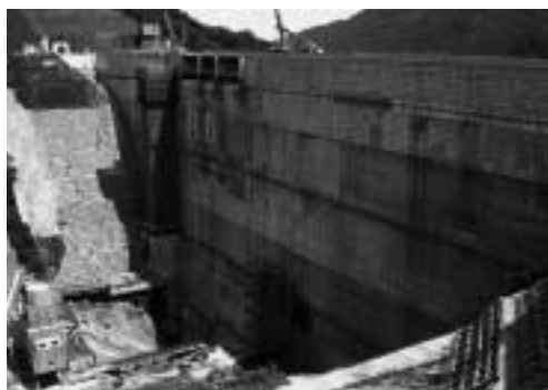
順調に工事が進む長井ダム
