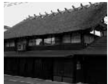
長井まちづくり基金事業で改修した歴史的建造物
