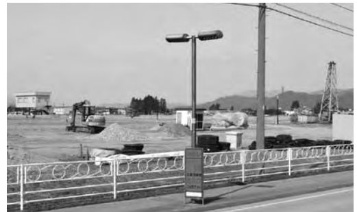
生涯学習プラザ運動公園の工事の様子
