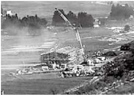
建設が進むバイオマス発電所
