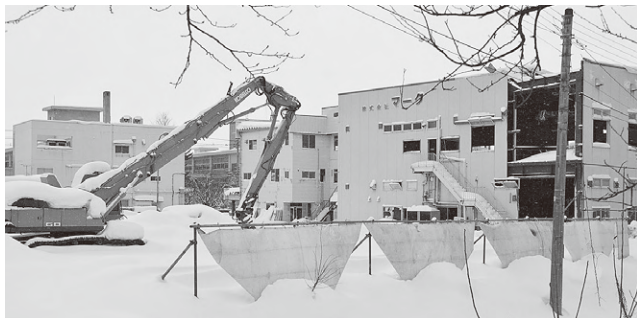
道の駅の建設が着々と進行
