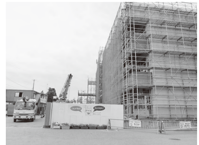
豊田小学校大規模改修工事の様子
