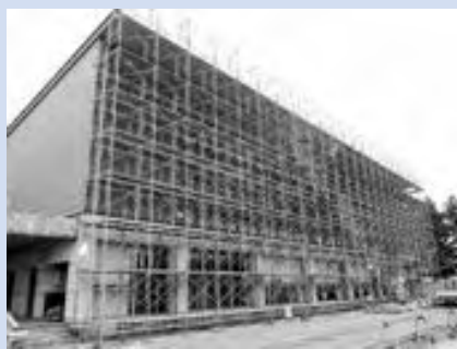
豊田小学校体育館大規模改修工事
