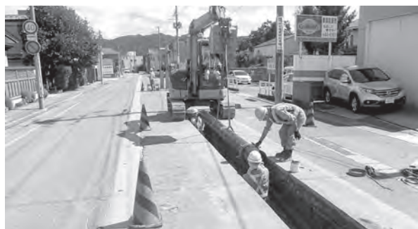
平山境町線配水管布設替工事
