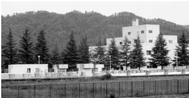
再生可能エネルギーが期待される下水道センター
