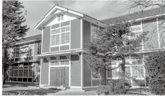
改修された旧長井小学校第一校舎
