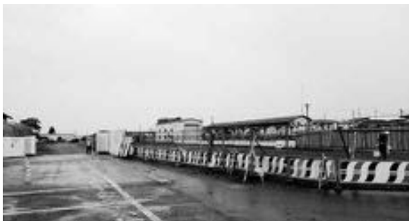
建設が始まった新市庁舎
