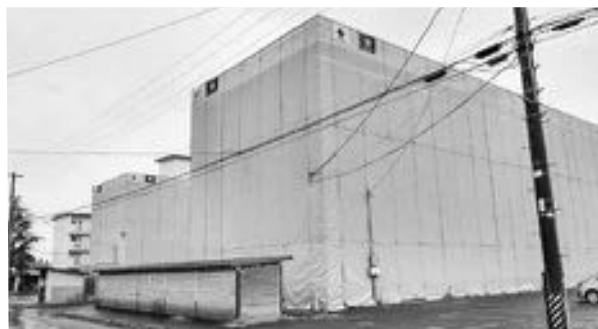
改修中の市営住宅
