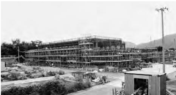
3月に竣工予定の学校給食共同調理場
