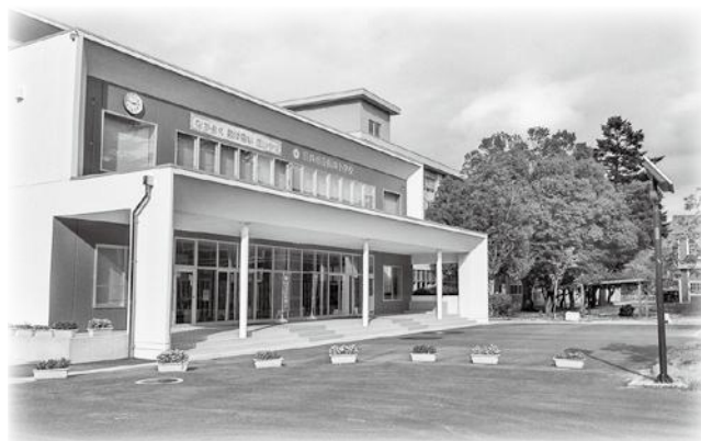
長井小学校管理棟建設事業 3億6,176万円
