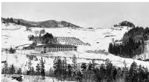
川西町の太陽光発電整備箇所
