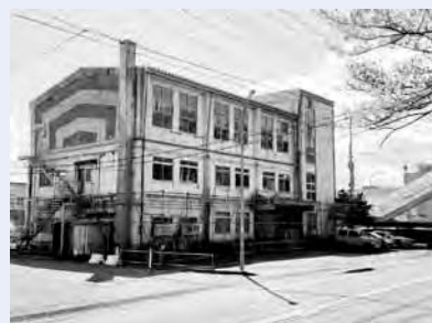
解体される旧第二庁舎
