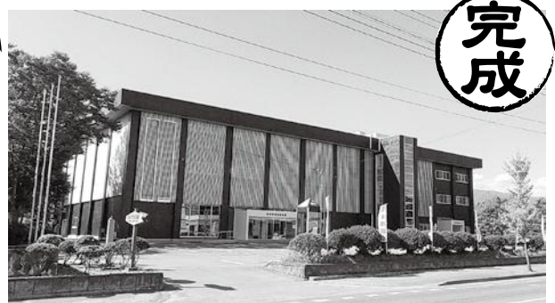
↑ 市民文化会館耐震等改修工事 4億4,170万円
