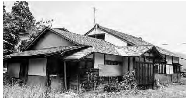
市内の空き家
