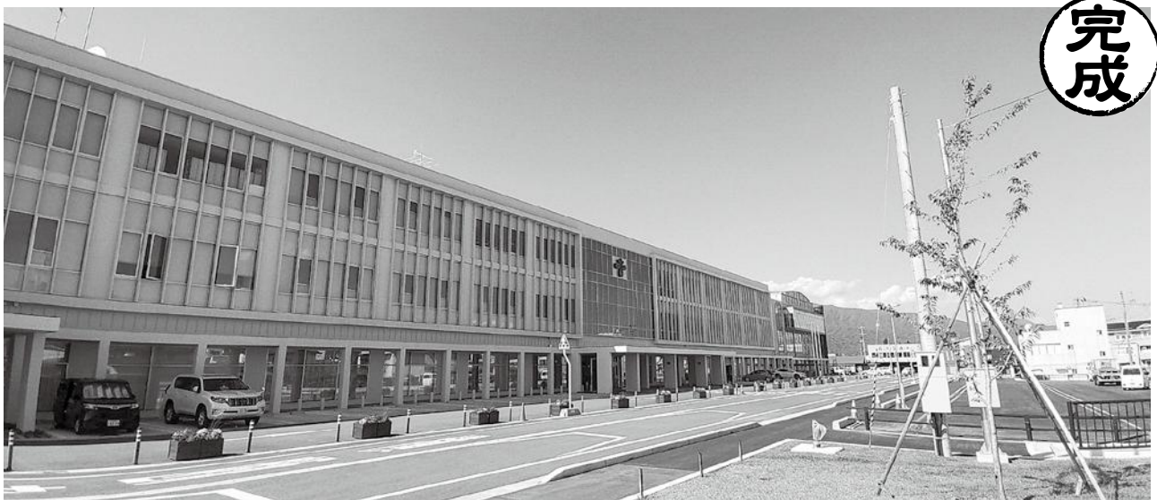
↑ 長井市新市庁舎建築工事 34億2,455万円
