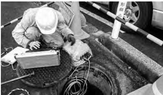
公共下水道の不明水調査
