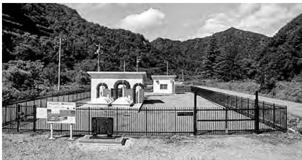
野川土地改良区の野川小水力発電所「のがわでんでん」
