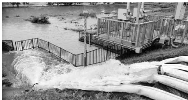
移動式ポンプ車による排水作業
