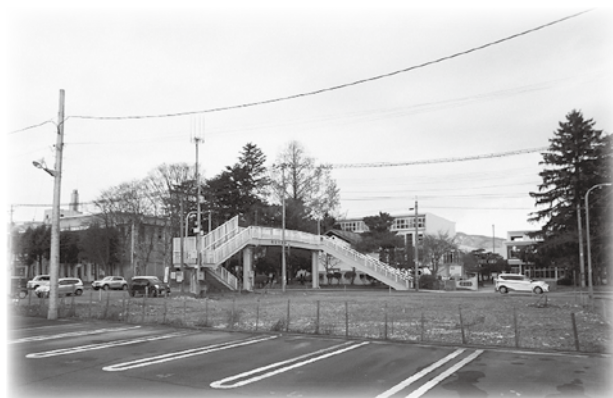
旧第二庁舎解体工事等（関係事業）7,030万円
