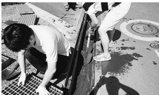
地域住民による側溝清掃
