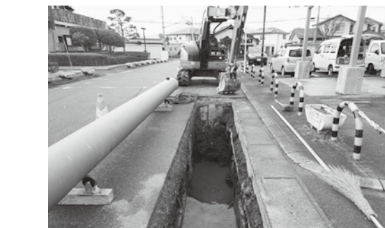
水道施設の耐震化工事
