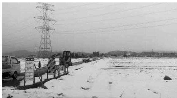
長井南産業団地予定地 (水道工事中)
