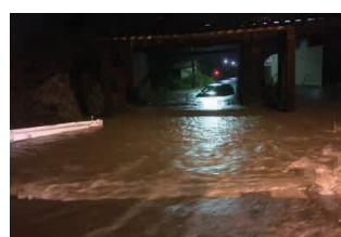
▲野川谷地線アンダーパスの浸水
