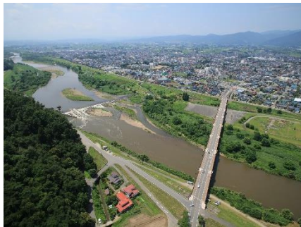
最上川上流域における長井の町場景観 (平成30年／国選定重要文化的景観)
