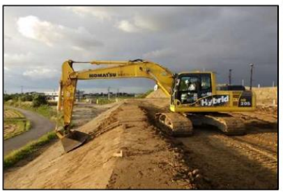
3DMGバックホウによる法面整形
