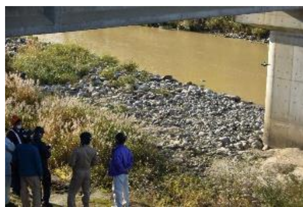
実際の橋梁での点検デモ
