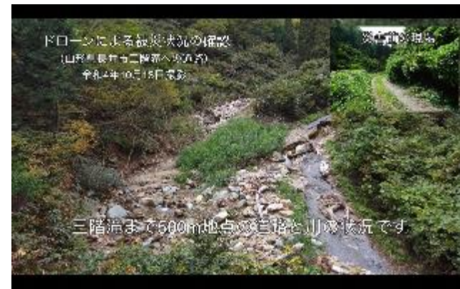
ドローンによる三階滝の被害状況の撮影
