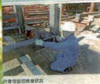
超音波探傷検査状況
