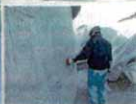
鉄筋探査に電磁波レーダー
