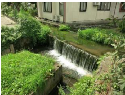
立体交差水路（大樋川と野呂川）
