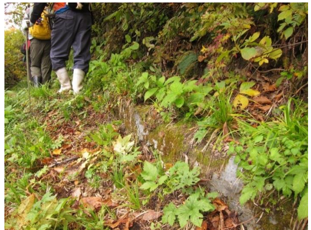
コンクリート製の構造物が残存
