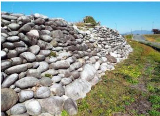
図 2-1-18 締切堤防の法面
