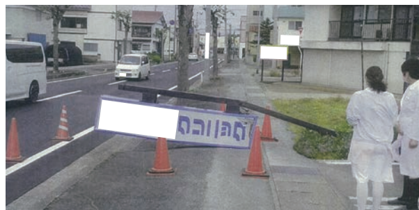
▲実際にあった屋外広告物(看板)倒壊の様子
