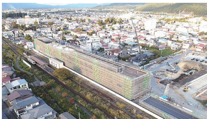
▲現在建設中の新庁舎（2020年10月23日撮影）。駅と一体化し、利便性を図ります。
