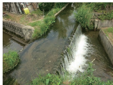
▲立体交差する大樋川と野呂川
