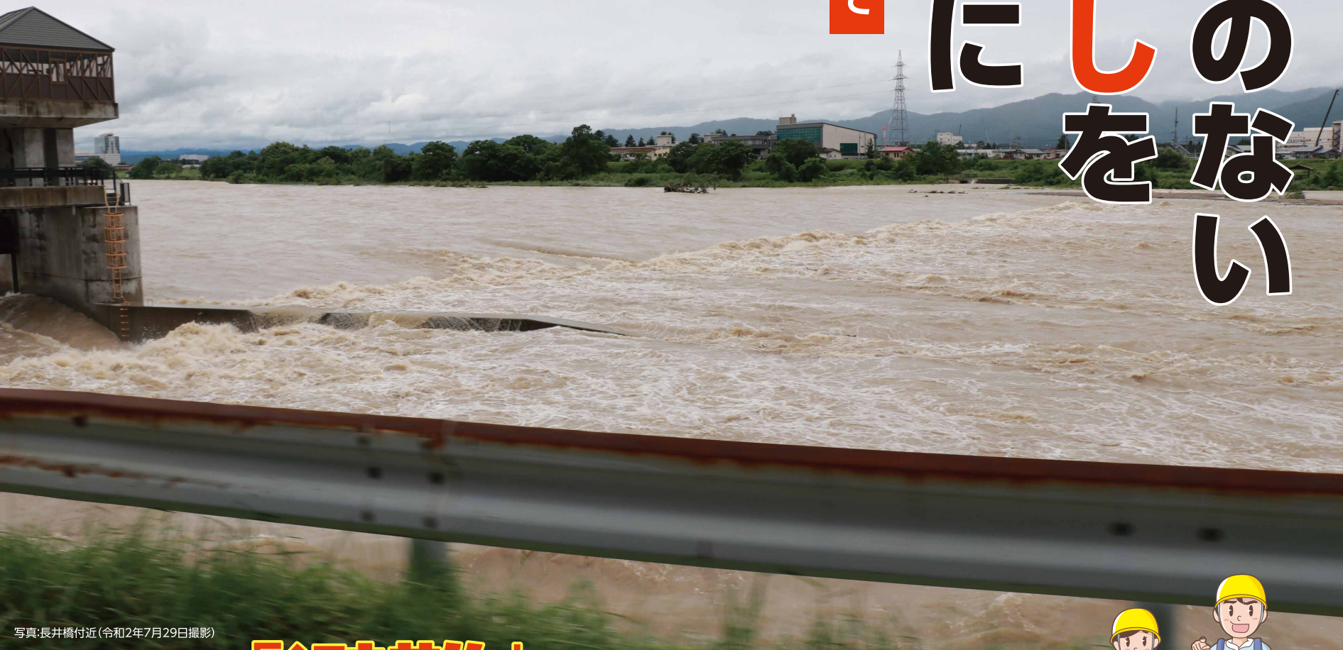
写真:長井橋付近(令和2年7月29日撮影)
