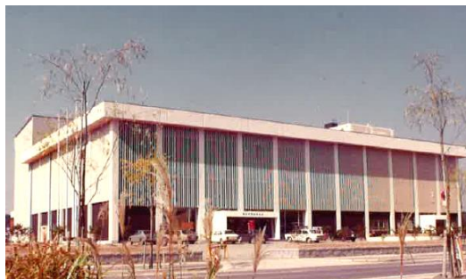
昭和49年竣工当時の長井市民文化会館
