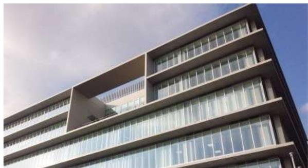
外壁・ガラス面に設置された庇の例
