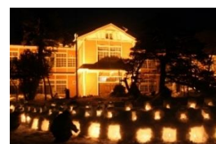
旧長井小学校第一校舎
