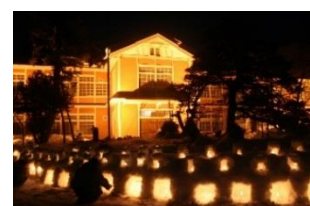
旧長井小学校第一校舎
